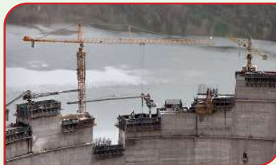
ساختن راه، سد و ساختمان
